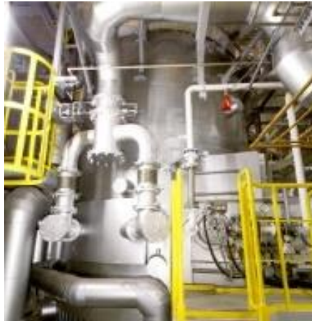
燃烧炉：滅分解ガスを完全燃焼しボイラへ
