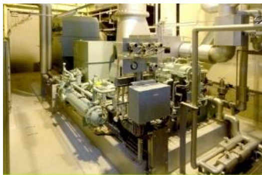
蒸気タービン発電機：視閲内地用と売電
